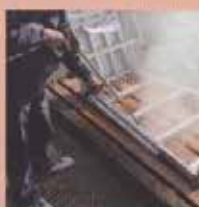
■仮設資材の洗浄
